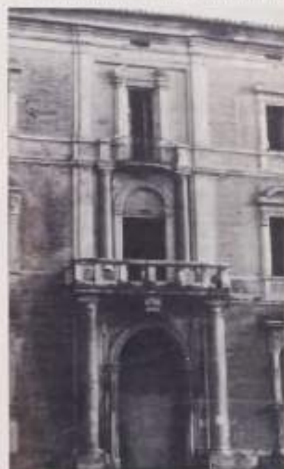
Fig. 18 - Il motivo centrale del portale e della facciata del piano nobile, prima degli interventi di restauro.
