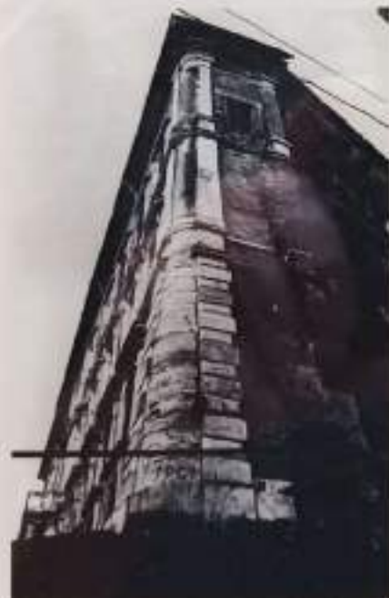
Fig. 19 - Angolo verso mare, prima degli interventi di restauro.
