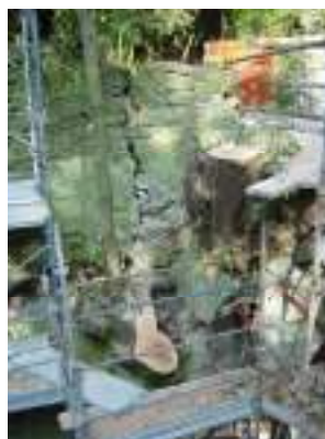
Fasi dell'intervento di restauro dell'uccelliera, con l'abbattimento dei grandi lecci a ridosso degli archi e il consolidamento degli stessi con nastri di fibre di carbonio.
