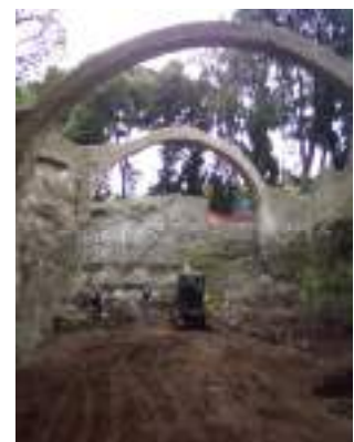
Fasi dell'intervento di restauro dell'uccelliera, con l'abbattimento dei grandi lecci a ridosso degli archi e il consolidamento degli stessi con nastri di fibre di carbonio.
