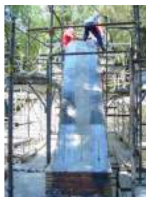
Fasi dell'intervento di restauro dell'uccelliera, con l'abbattimento dei grandi lecci a ridosso degli archi e il consolidamento degli stessi con nastri di fibre di carbonio.
